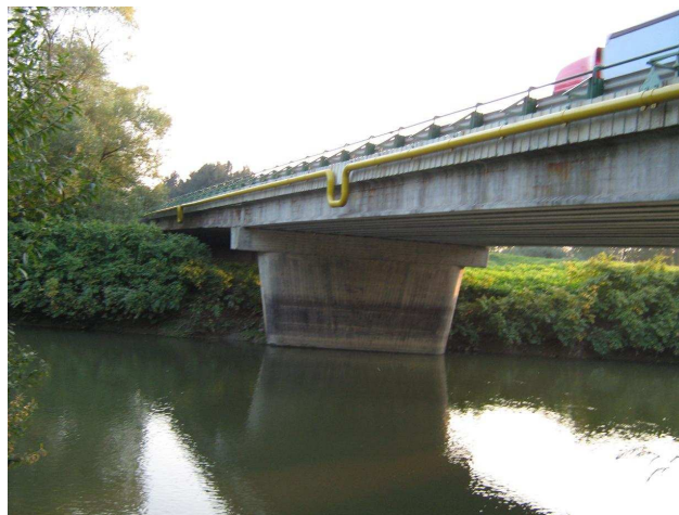
Rába-híd 86-os főút Körmen
